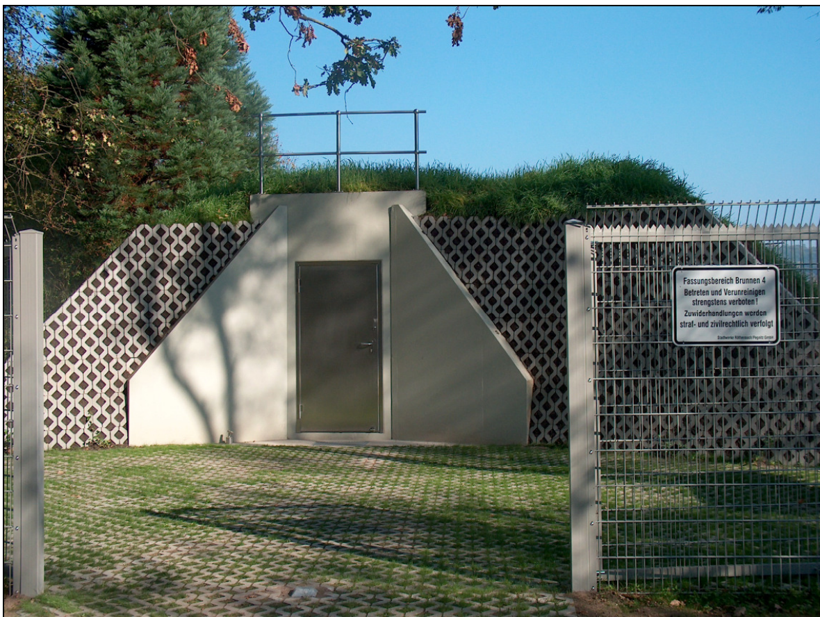
Abb. 1: Ansicht der Brunnenstation
