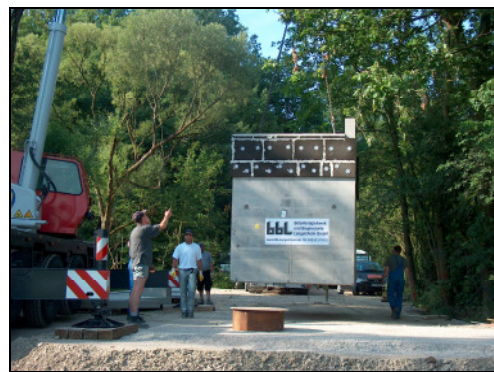
Abb. 4: Millimetergenaues Aufstellen der Fertigstation
