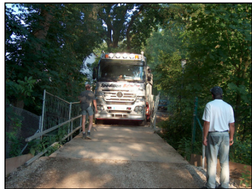
Abb. 3: Antransport der Fertigstation
