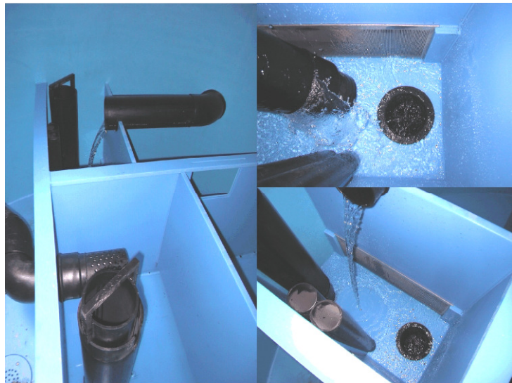
➤ Quellsammelschacht mit Mehrkammersystemkonzepten
