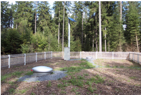
➤ Fassungsbereich nach der Sanierung
