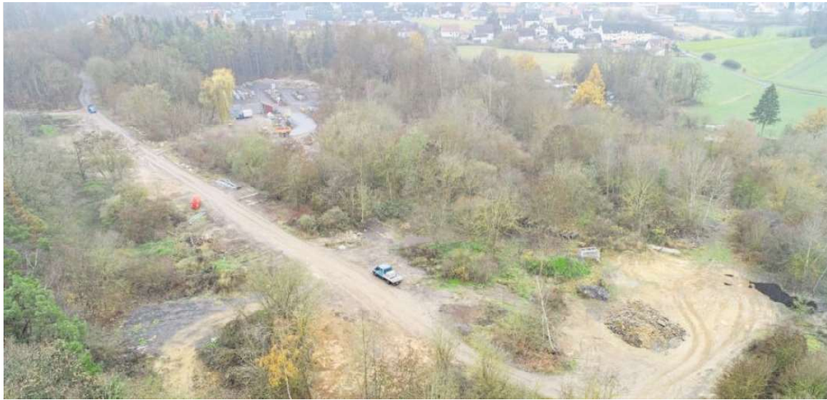
Blick auf die zentrale Fläche des Sanierungsgebietes. Die Einrichtungen des städtischen Bauhofes wie etwa die Salzsilos müssen komplett weichen. Bild: Thilo Hierstetter
